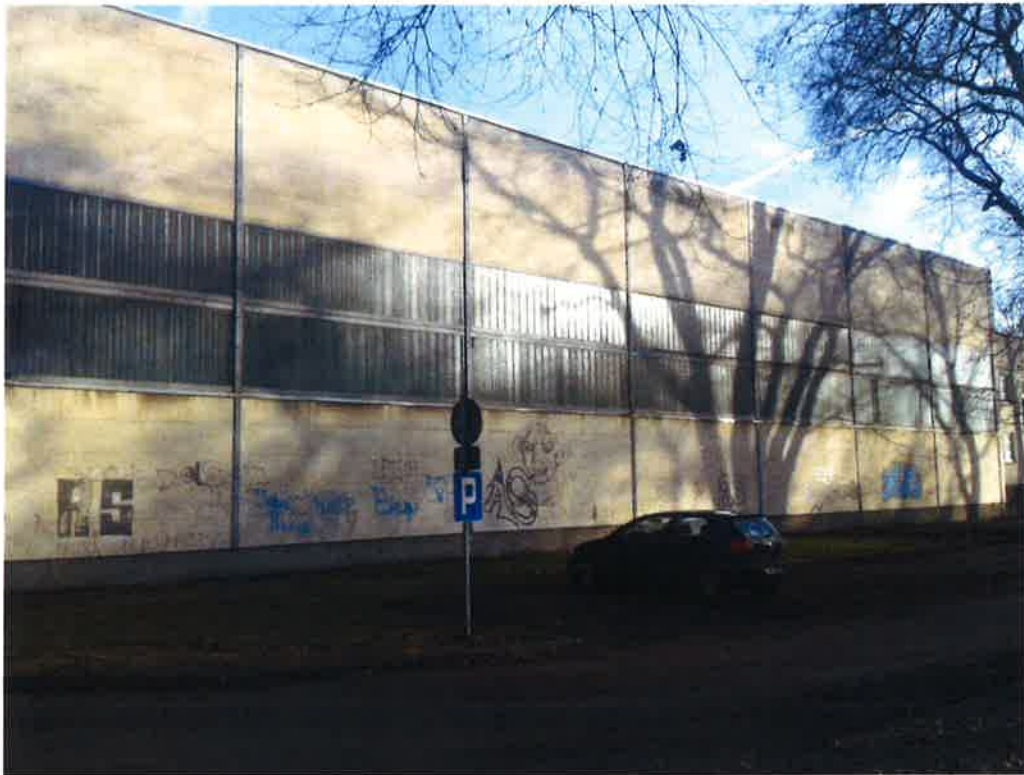
fot. nr 3: elewacje SW
