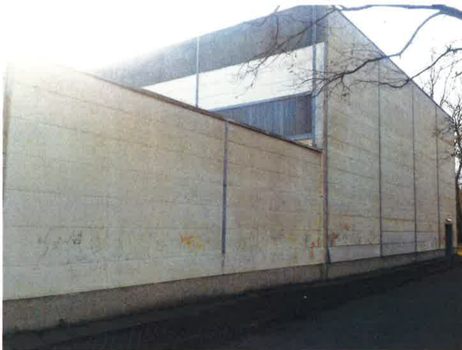
fot. nr 1: elewacja NW
