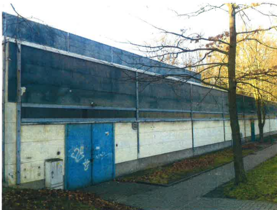
fot. nr 2: elewacja NE
