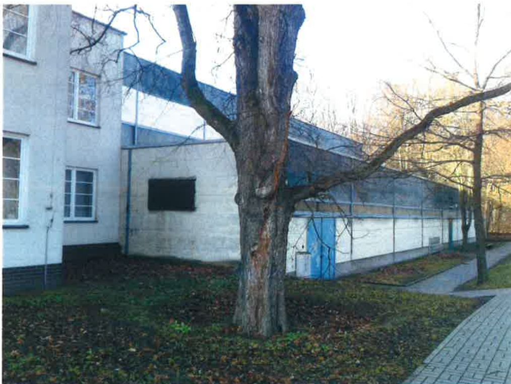
fot. nr 4: elewacja SE
